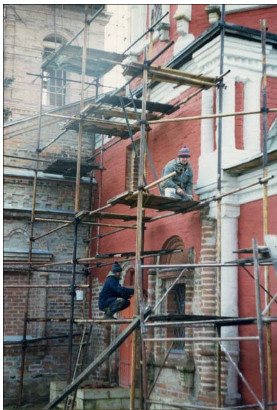
Покраска фасада, 1998 г.
