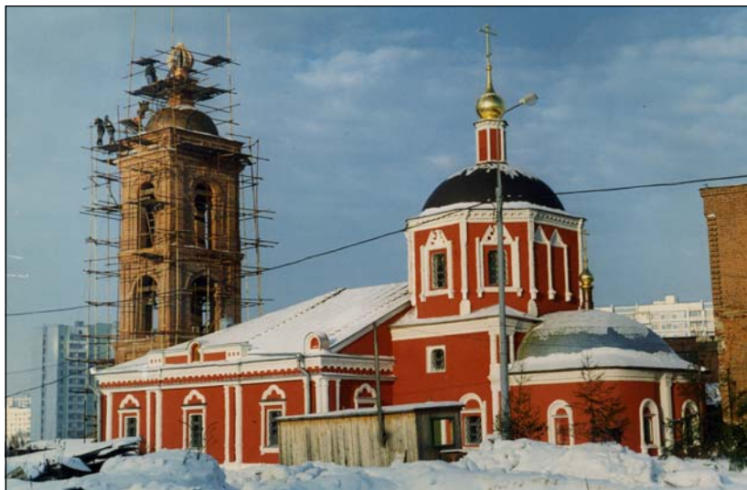
Завершение работ по возведению колокольни. 1997 г.
