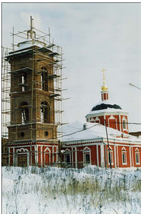
Возведение колокольни, 1997 г.
