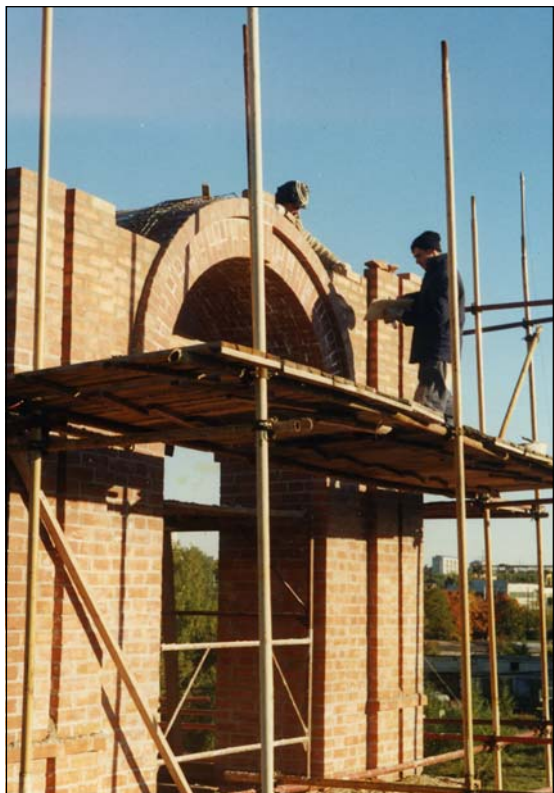
Работы на втором ярусе колокольни, 1996 г.
