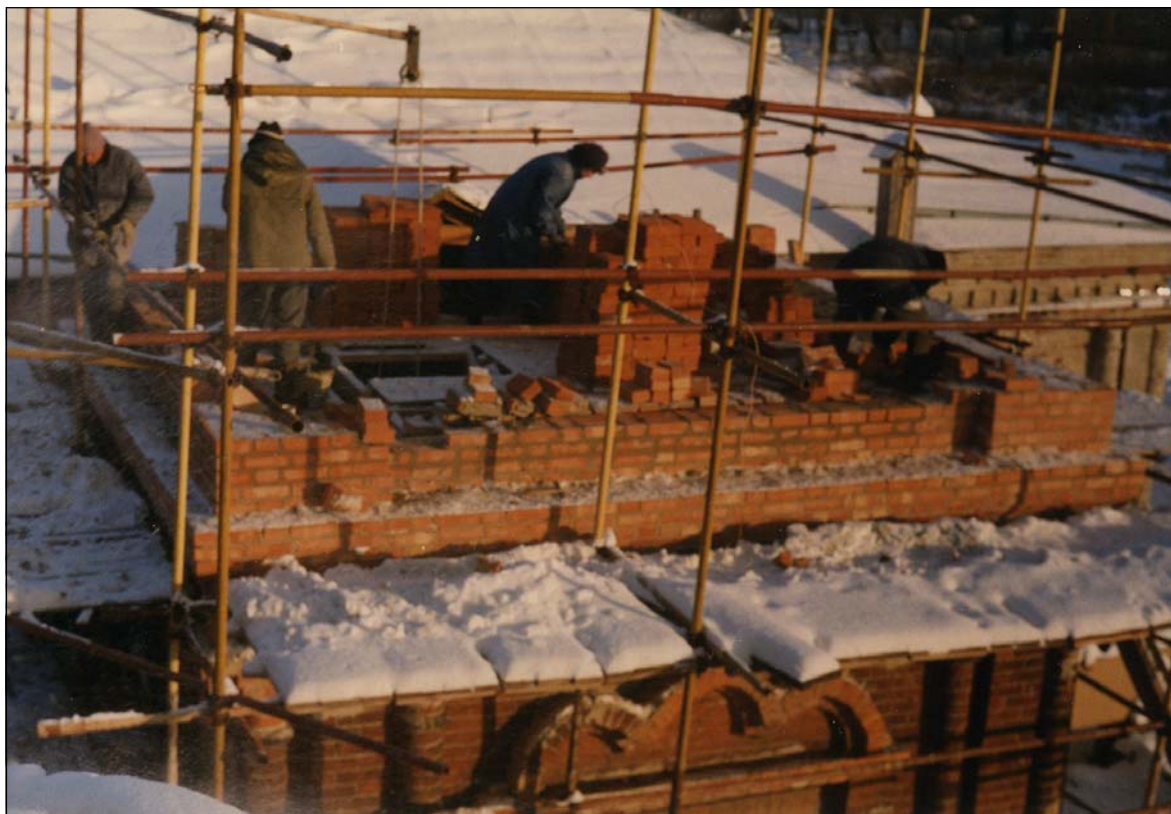
Возведение первого яруса колокольни, 1996 г.
